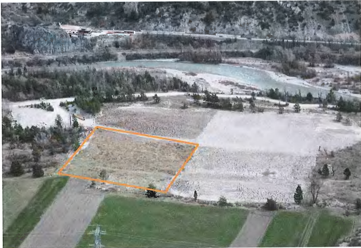
Figure 42 : Vue du casier 2 depuis la RD38 (Mars 2023)
