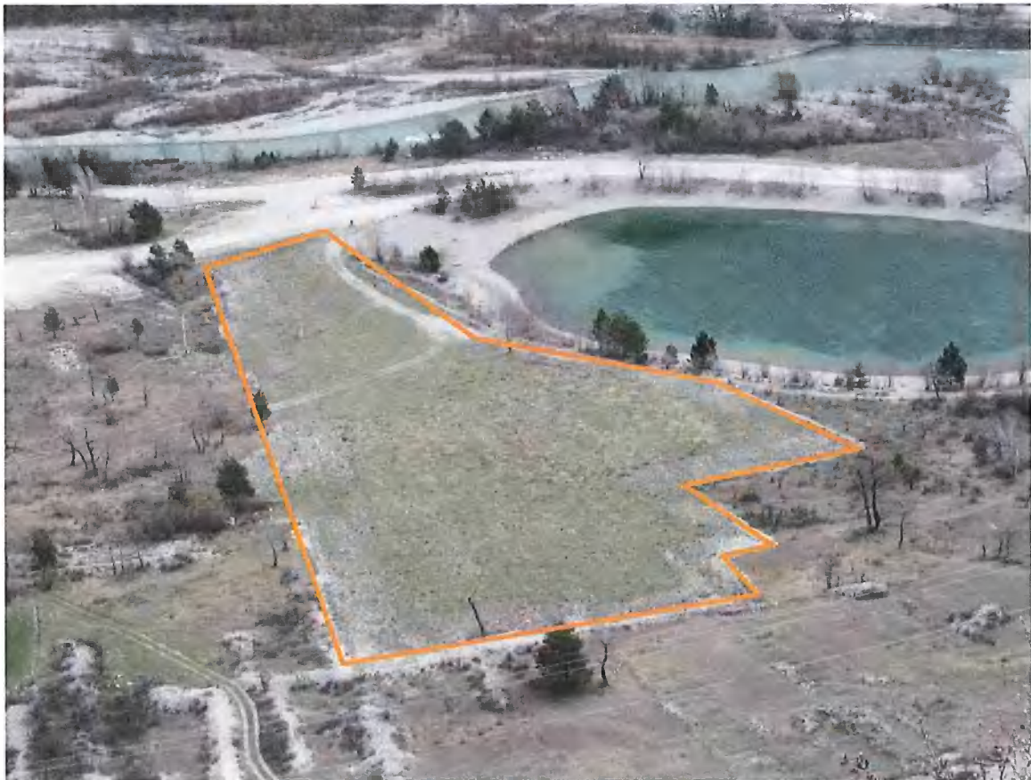
Figure 40 : Vue du casier 1 depuis la RD38 (Mars 2023)
