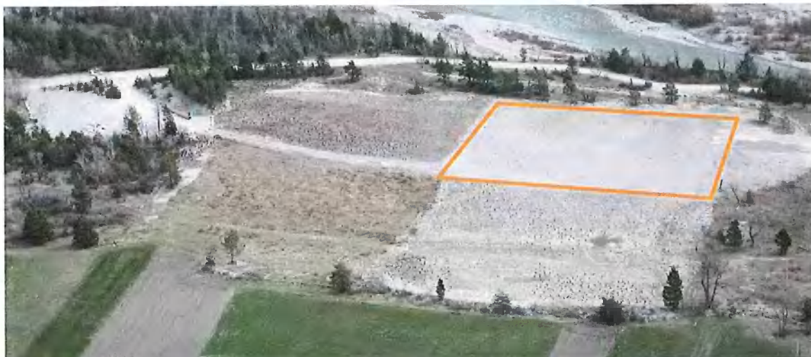
Figure 49 : Vue du casier 5 depuis la RD38 (Mars 2023)
